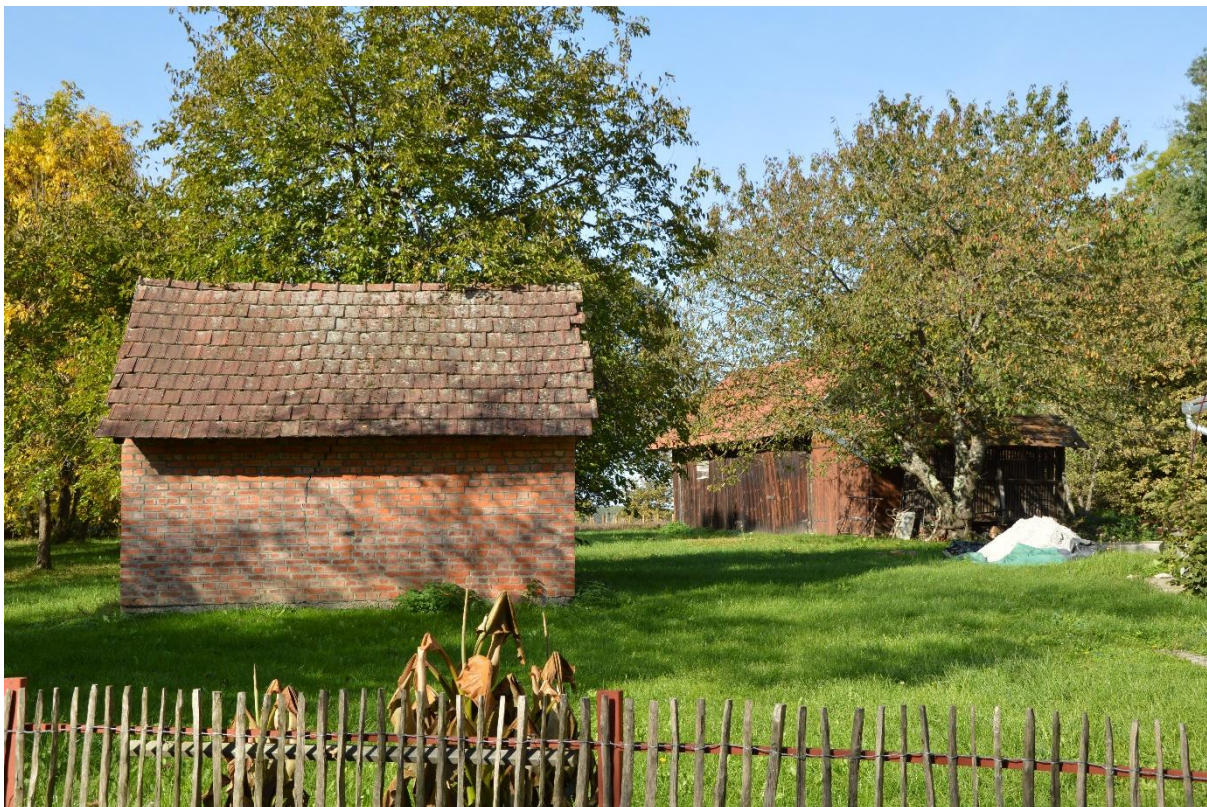
Hagyományos falusi gazdálkodáshoz szükséges mezőgazdasági épületek (pajta)
